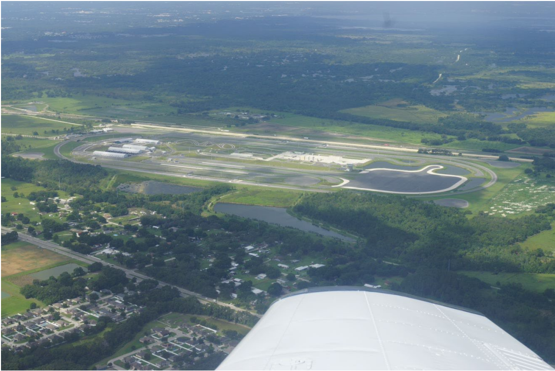
SUNTRAX Test Facility
